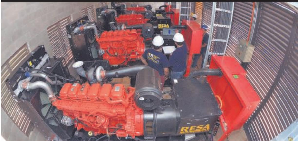
4 Grupos Generadores abiertos de 550/500 kVA con motor SCANIA en sincronismo paralelo + Transformador elevador seco de 2000 kVA WEG.
